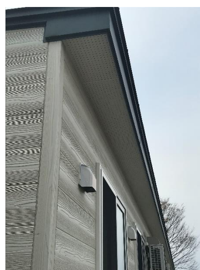
R2.3 本館 軒天工事↑
