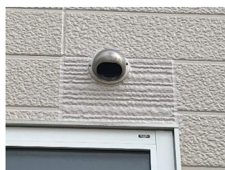
←R2.3 GH棟洗面所壁工事(内外)
